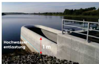
Talsperre Döllnitzsee Länge HWE ca. 35 m, Höhe ca. 5,5 m, Beton sichtbar bis OK Überlauf ca. 1 m
