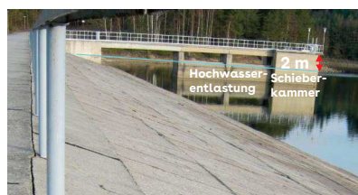
Talsperre Heyda Länge HWE ca. 24 m, Höhe ca. 17 m, Beton sichtbar bis OK Schieberkammer ca. 2 m
